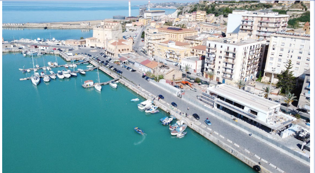
Lavori di realizzazione del nuovo terminal passeggeri di Porto Empedocle
